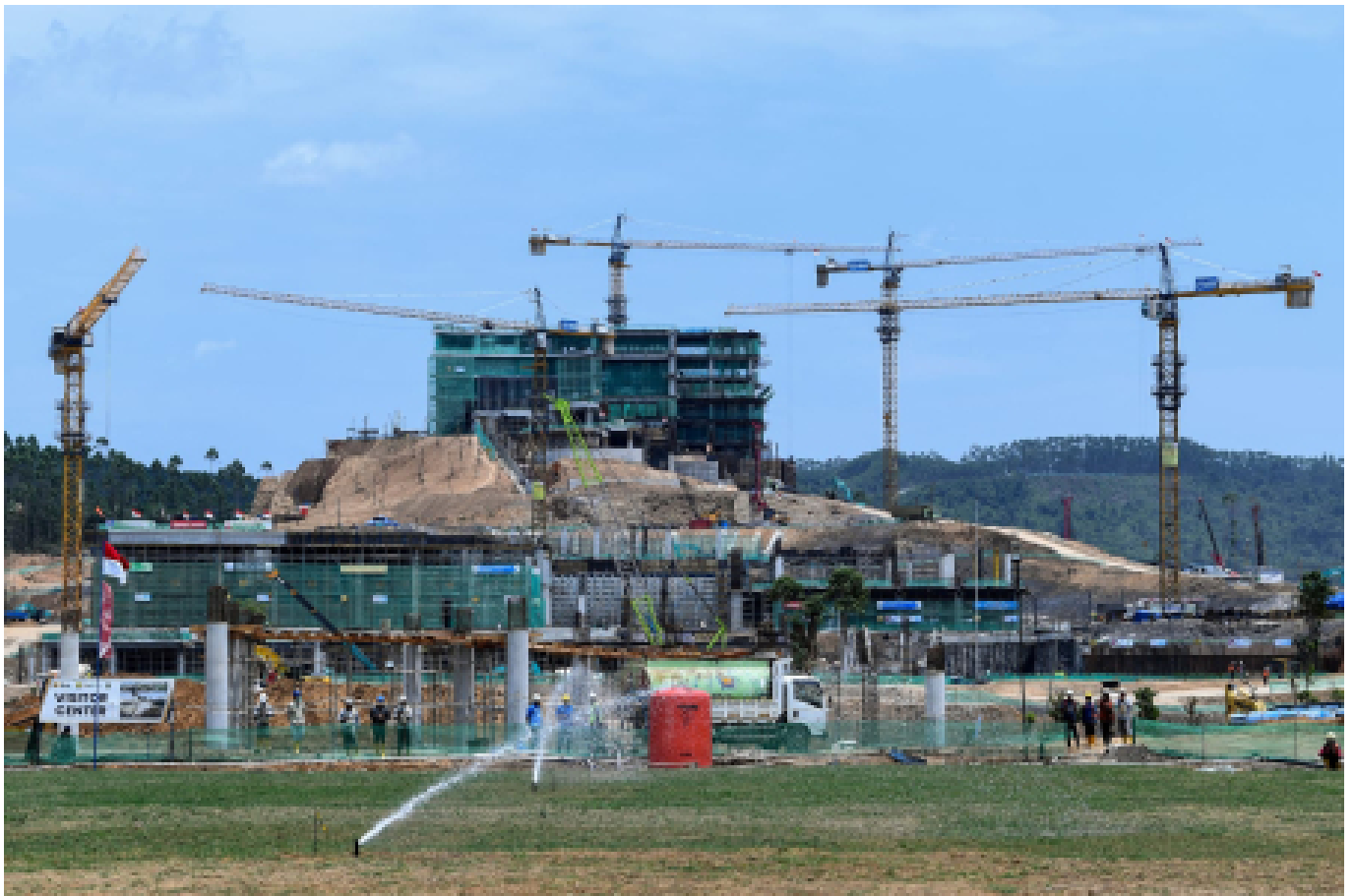
Pekerja di kawasan pembangunan IKN (Ibu Kota Negara) – indonesia.go.id
