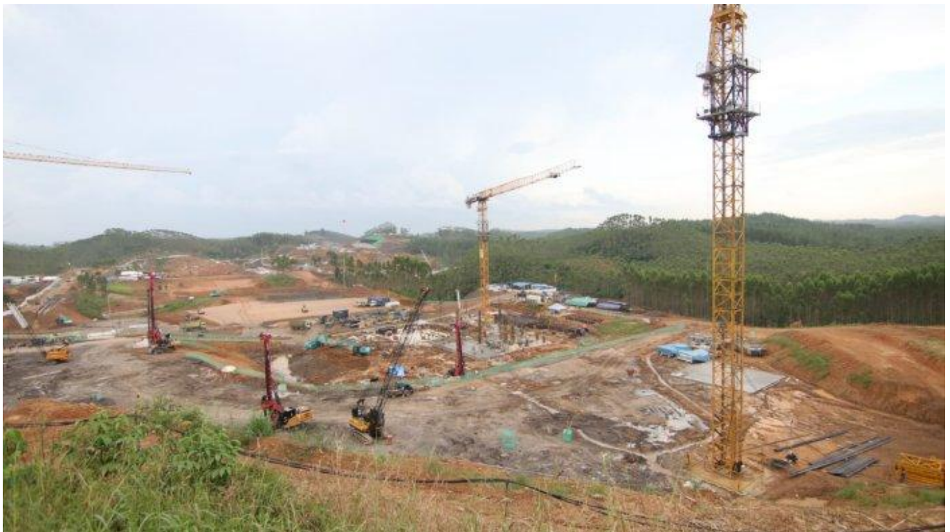
Progres pembangunan IKN Nusantara terkini - tribunnews
