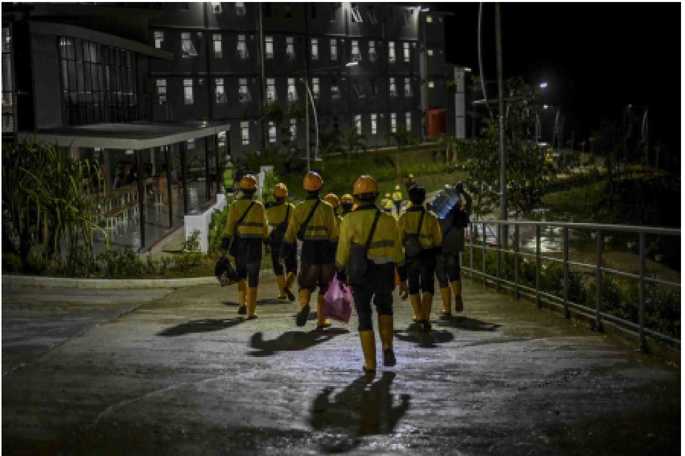
Pekerja konstruksi di Ibu Kota Nusantara, Kalimantan Timur, beraktivitas di proyek Istana Negara – Antara Foto
