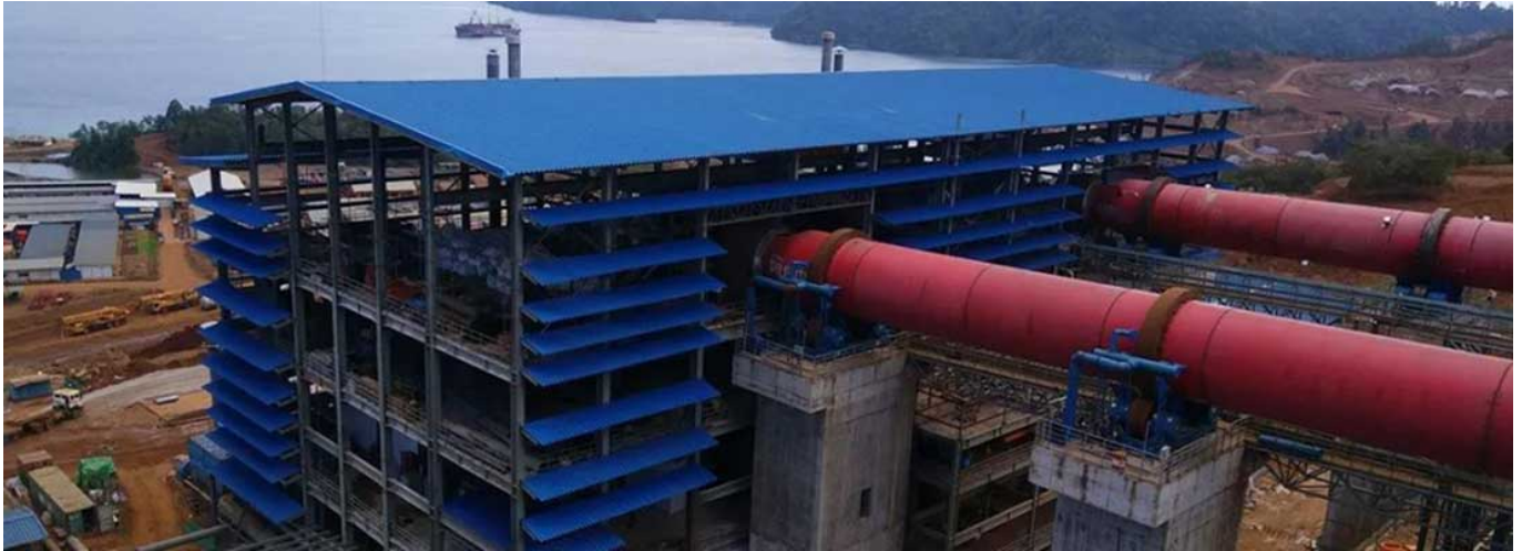
Pabrik peleburan nikel yang sedang dibangun - rotarykilnfactory
