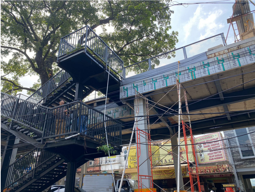
Kabel semrawut di kawasan Skywalk Cihampelas.
