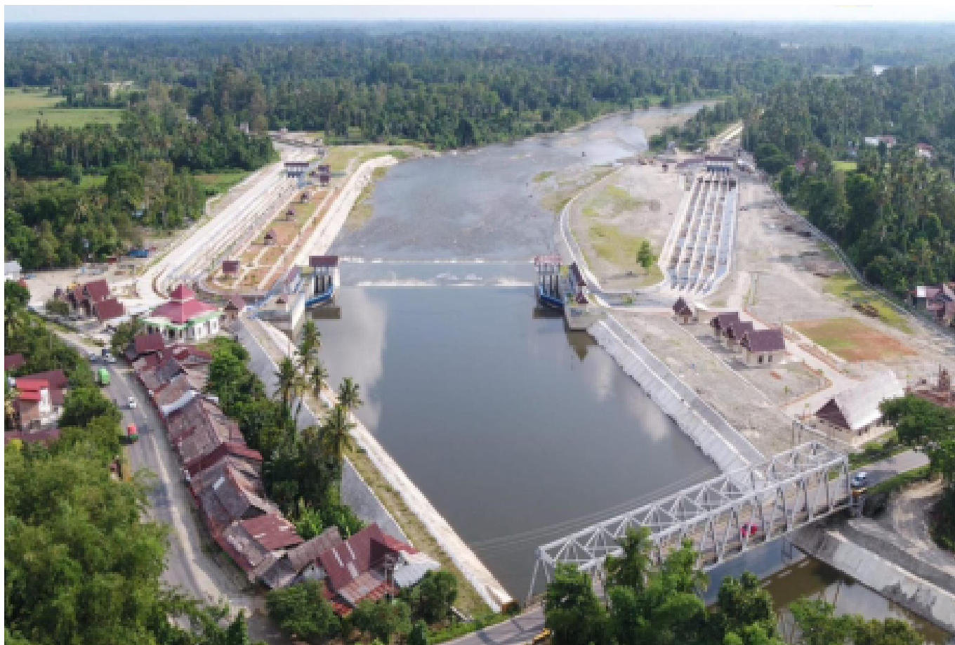
Pemandangan udara Bendungan Baliase yang megah, menjadi titik sentral pengairan bagi ribuan hektare sawah di Luwu Utara – KEMEPUPR
