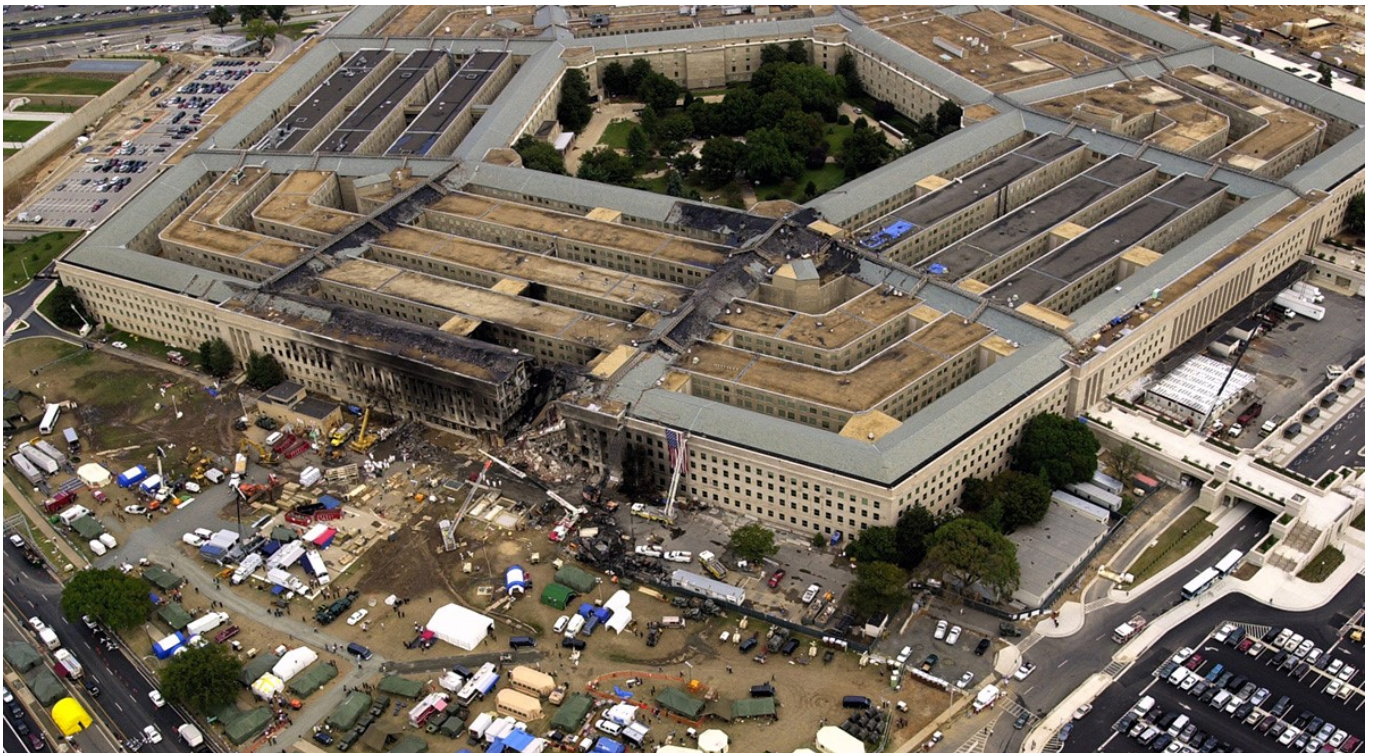
Foto udara dua hari setelah serangan, menunjukkan sisi Gedung Pentagon di Washington hancur ditabrak pesawat penumpang yang dibajak teroris. - National Archives Catalog
